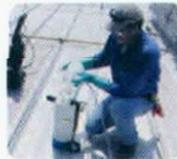
2 El área debe estar bien ventilada. Verifique el buen funcionamiento del aspersor y que el tanque no tenga fugas.
