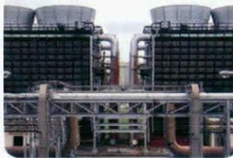
**4** Drene totalmente el agua del sistema y rellene con agua limpia. En sistemas donde no puede drenarse totalmente por condiciones especiales del proceso, sugerimos que aumente la purga 2 ó 3 veces hasta diluir totalmente el concentrado.
